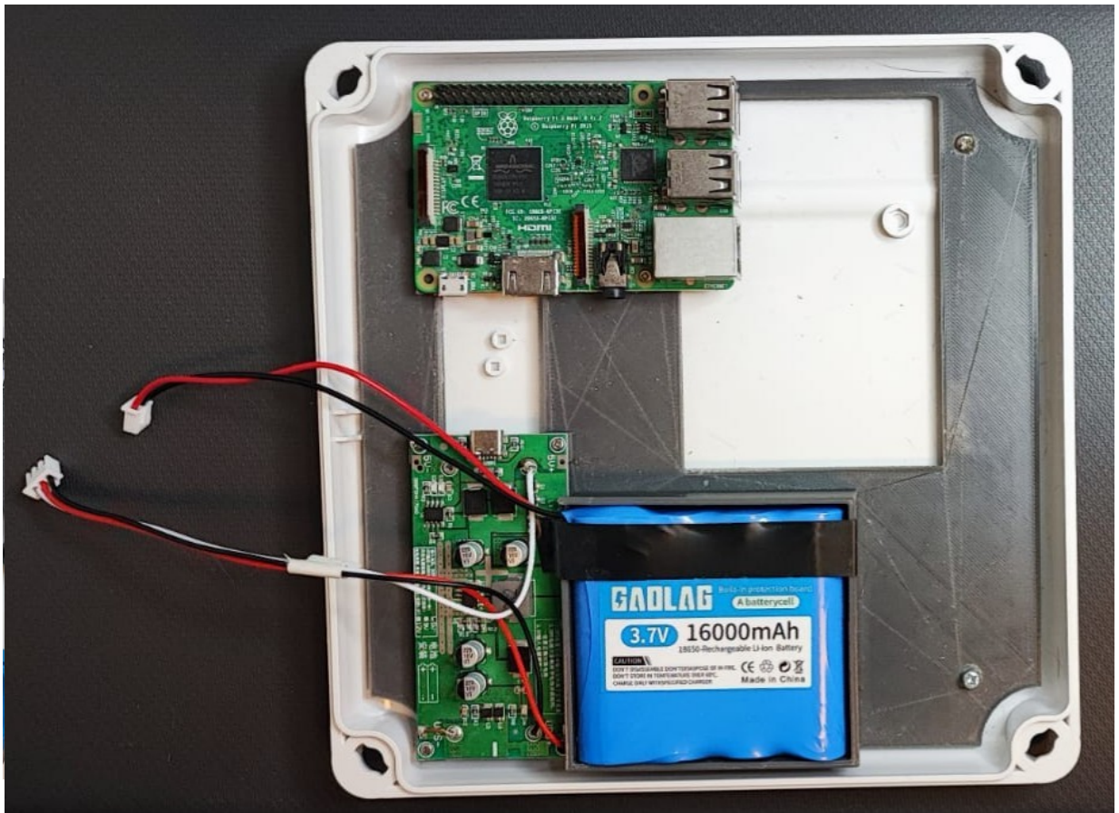
Figure 12 : Montaggio UPS + Batteria LiPo + Raspberry nel coperchio di un contenitore JE-200
